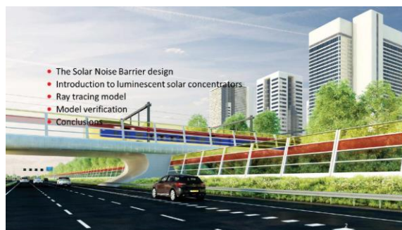
蛍光型太陽光集光板（太陽電池） を用いた騒音障壁（イメージ図）
