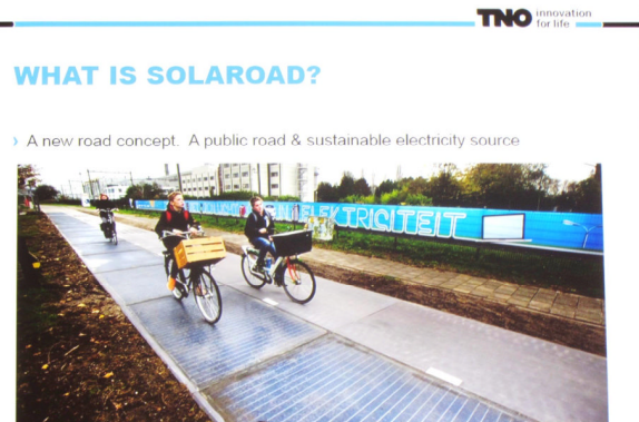
太陽電池道路 : Solar Road の実験道路
